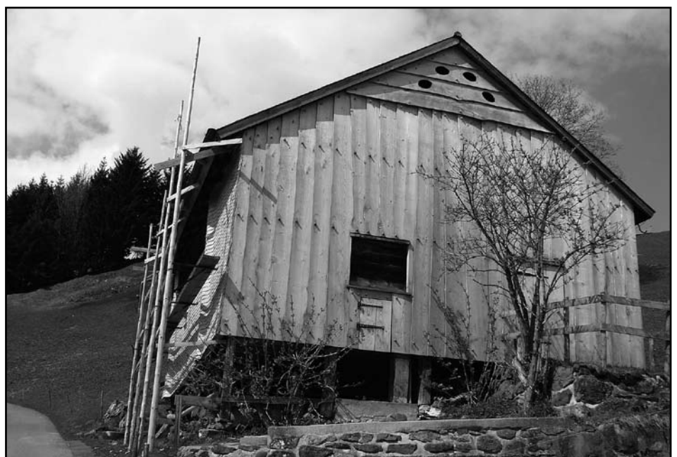
Eine gelungene Sanierung ist Karl Stieger, Muntlerentsch, gelungen. Sein Stall in der Röhrlwiid wurde nach alter Handwerkskunst renoviert. Kompliment!
