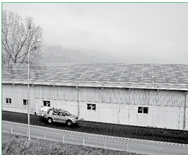
Wesentlich grössere Anlage auf dem Dach der neuen Markthalle
