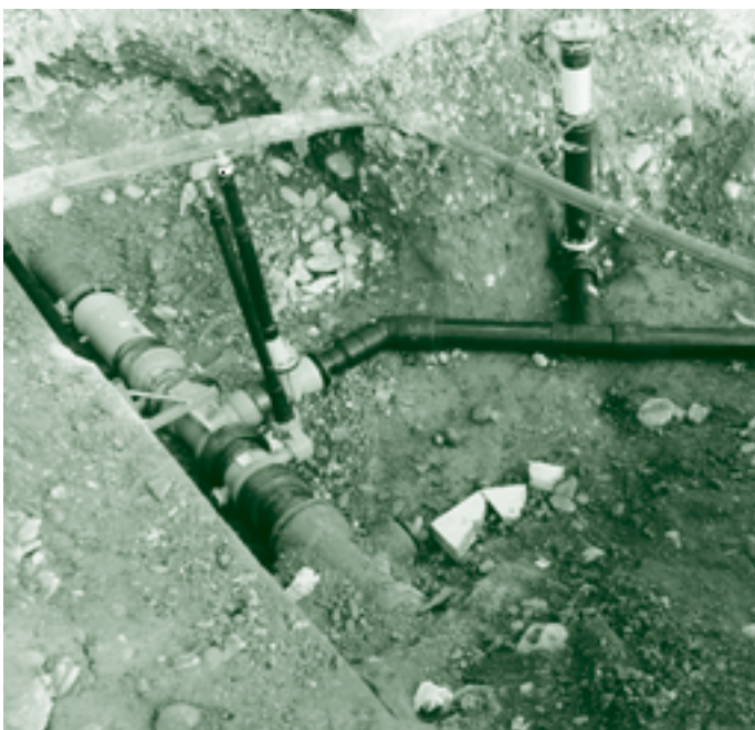
Combi Einbau mit Neuanschluss Wassergasse
