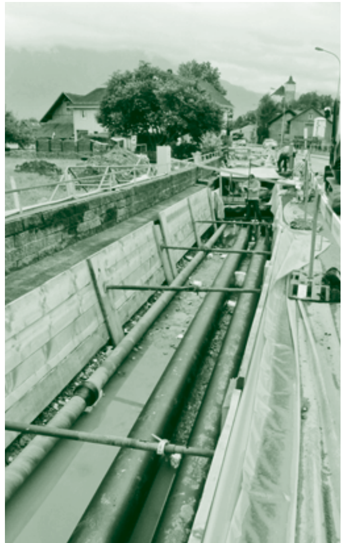
Leitungsbau parallel zur Fernheizung
