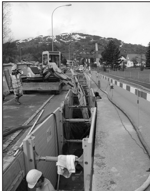
Meteorwasserleitung bei Firma Bradford. Gewerbestrasse gebaut. Die Sanierungsarbeiten der Strom- und TV-Anlagen können somit 2006 abgeschlossen werden.
