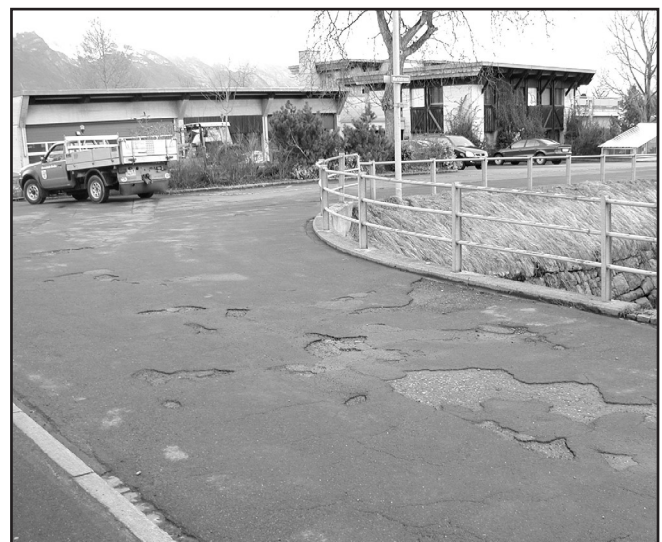
Die zu sanierende Brücke Nr. 7 / Zufahrt Werkhof West.
