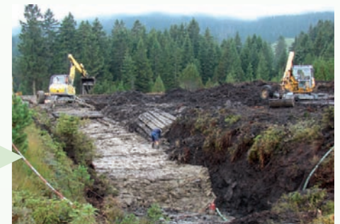
Bau von total drei mit Lehm verfüllten Holzkästen quer zum Graben als Basis für den Wassereinstau und zur Sicherstellung der angestrebten Staukote im stark geneigten Grabenabschnitt
