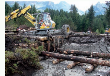
Bau von total drei mit Lehm verfüllten Holzkästen quer zum Graben als Basis für den Wassereinstau und zur Sicherstellung der angestrebten Staukote im stark geneigten Grabenabschnitt
