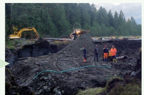
Niederbringen von Spundwänden im Anschluss an die Holzkästen zur Verlängerung der Fliesswege des Wassers. Diese verlangsamen die Geschwindigkeit der Wasserströme und reduzieren Erosionen im Torf- bzw. in den Baukörpern
