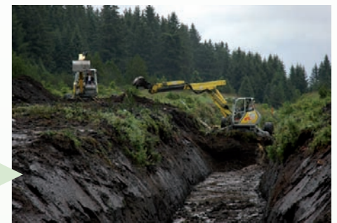
Aushub der Grabensohle bis auf den lehmigen, standfesten Untergrund
