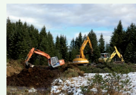
Vorschüttung von Torf an die Dammkörper. Astmaterial schützt gleichzeitig den Dammkörper vor Wellenschlag und bildet ein Substrat für die Ansiedlung von Torfmoosen
