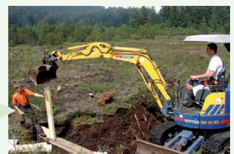
Vorschüttung von Torf an die Dammkörper. Astmaterial schützt gleichzeitig den Dammkörper vor Wellenschlag und bildet ein Substrat für die Ansiedlung von Torfmoosen
