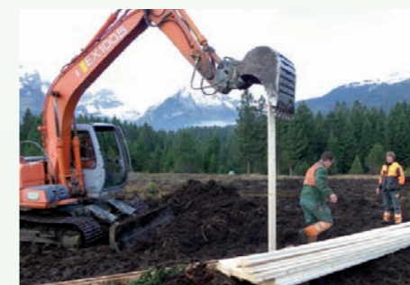
Niederbringen von Spundwänden im Anschluss an die Holzkästen zur Verlängerung der Fliesswege des Wassers. Diese verlangsamen die Geschwindigkeit der Wasserströme und reduzieren Erosionen im Torf- bzw. in den Baukörpern
